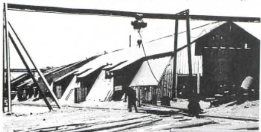
Участок изготовления тары. Неотопляемый производственный корпус.
