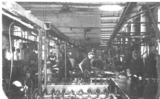
Установка проверки газовых кранов на герметичность. Цех № 3.
