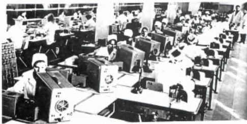
Конвейер сборки и монтажа печатных плат аппаратуры "Весна".
