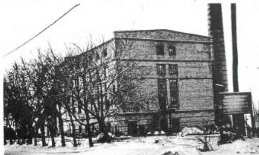
Заводская котельная. Многие десятилетия руководил котельной ветеран труда И.Г.Ковалев.
