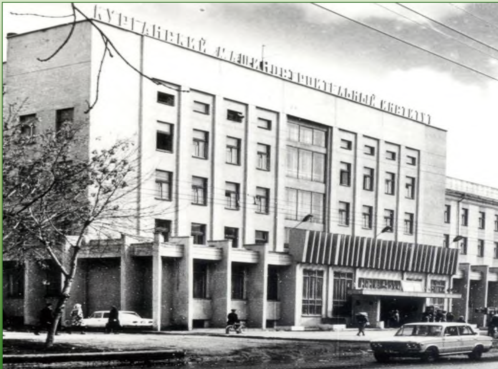
Здание Машиностроительного института. Курган. 1978 г.
